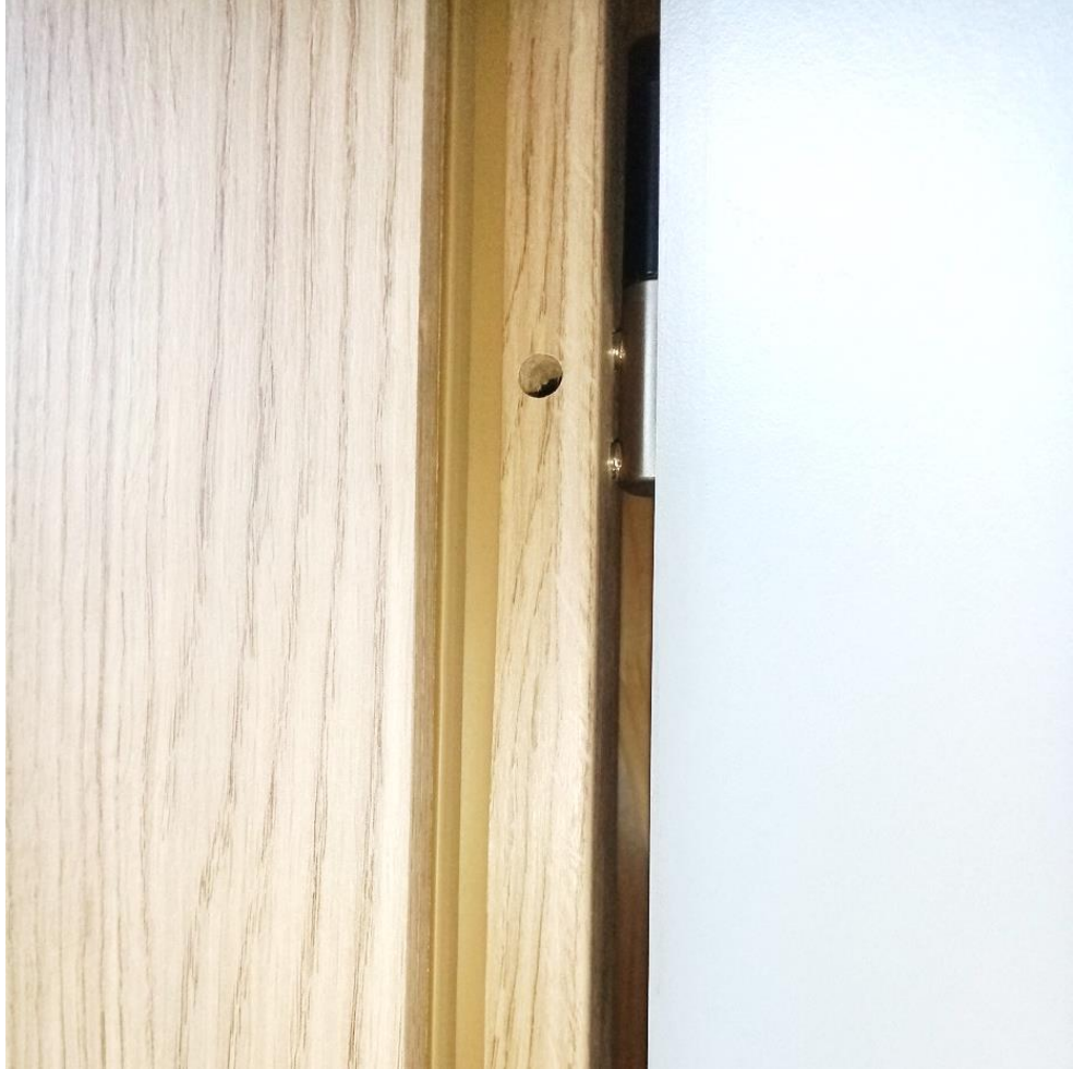
Detail těsnění u nového OKZ
